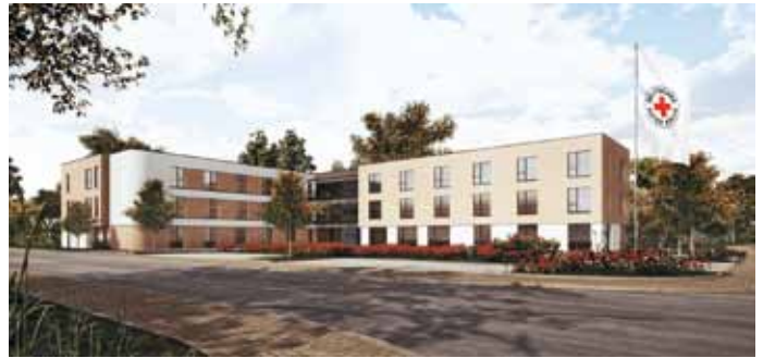
Ansicht des DRK-Neubaus in Sangerhausen – Mitte 2021 ist die Fertigstellung geplant
