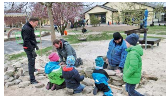
Kinder und Eltern bauen gemeinsam die Natursteinmauer für die Matschküche
